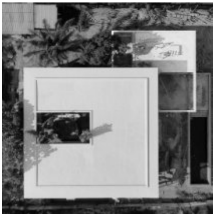
Cubierta en obra
