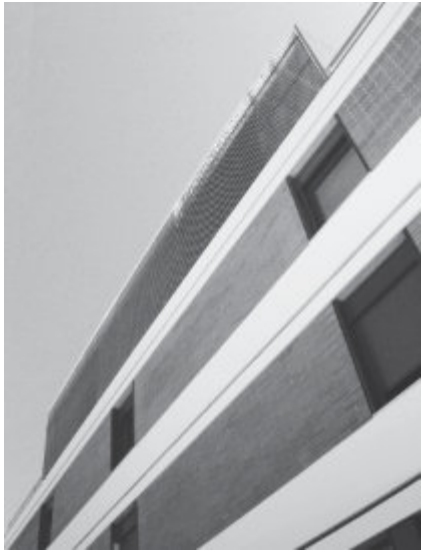
Detalle fachada norte
