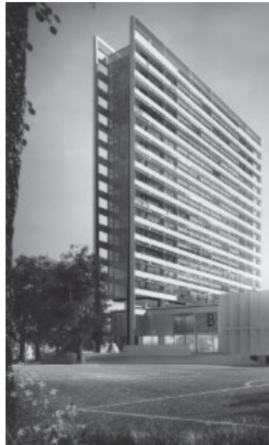
Viviendas, servicios y comercios, Santa Cruz de la Sierra, Bolivia, 75.550 m2. (E N C I A M) Jorge Gambini y Joaquín Callau
