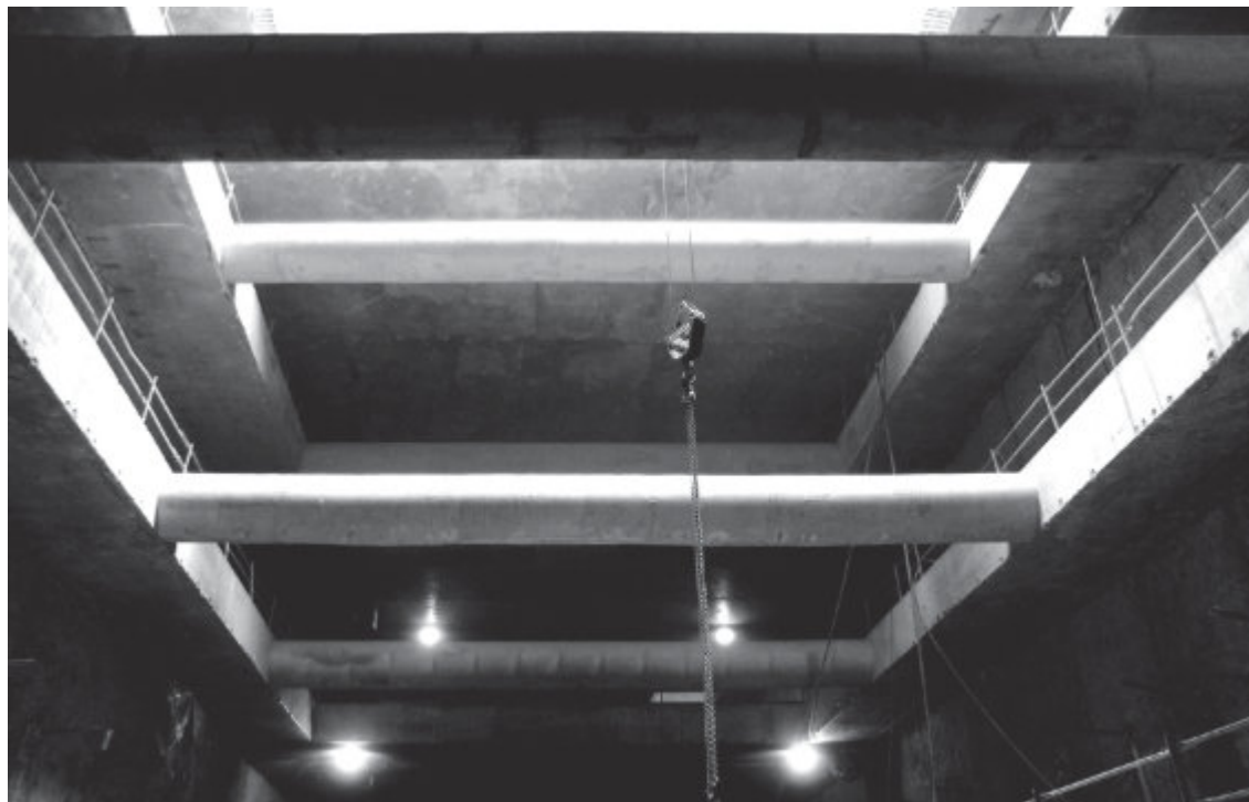
Vista del falso túnel sobre la contra bóveda
