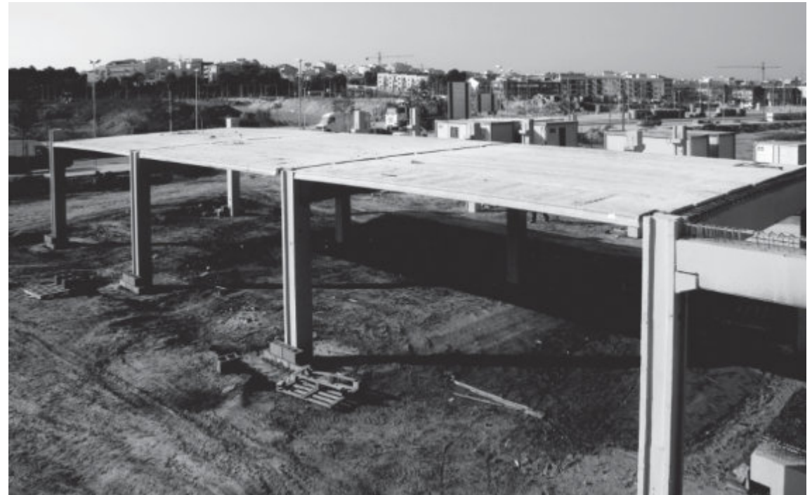
Montaje de la estructura prefabricada
