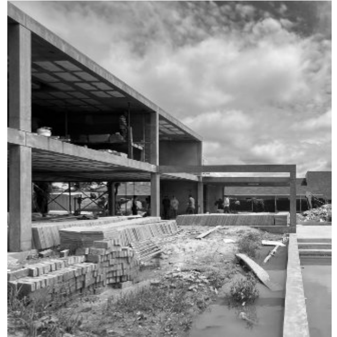
Imagen en escorzo de la fachada posterior en obra
