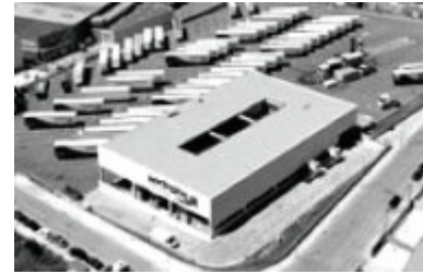
Instalaciones para control de flota vehículos Sertrans en Lliçà de Vall,
