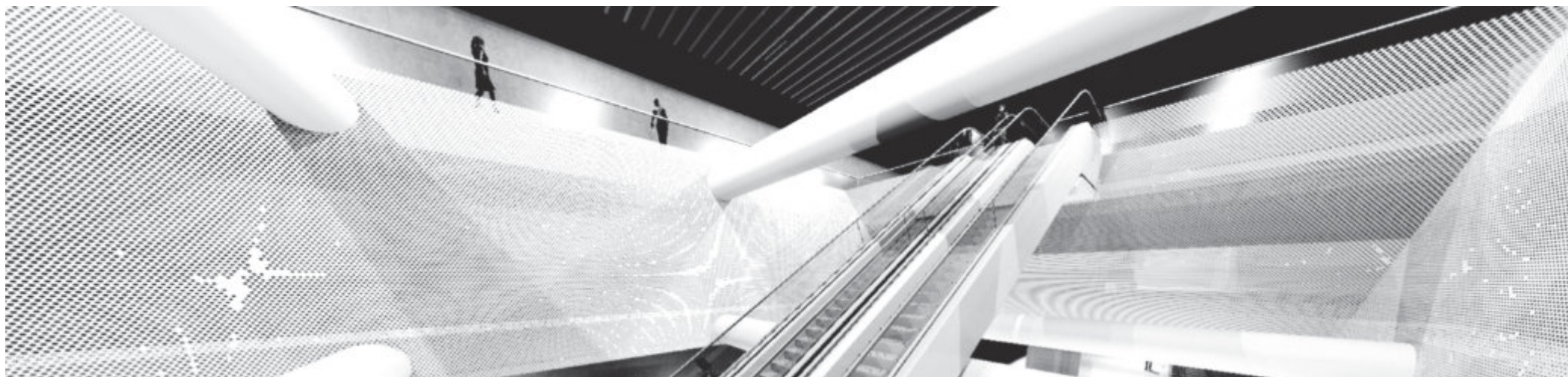
Escaleras mecánicas a la zona de andenes desde el nivel -4 (instalaciones técnicas)
