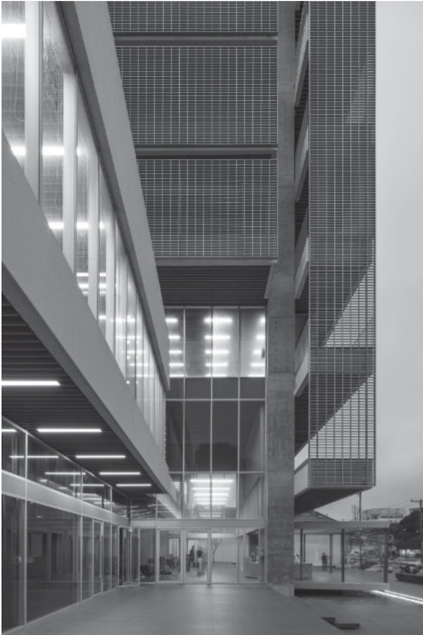
Vista de la plaza de acceso al edificio
