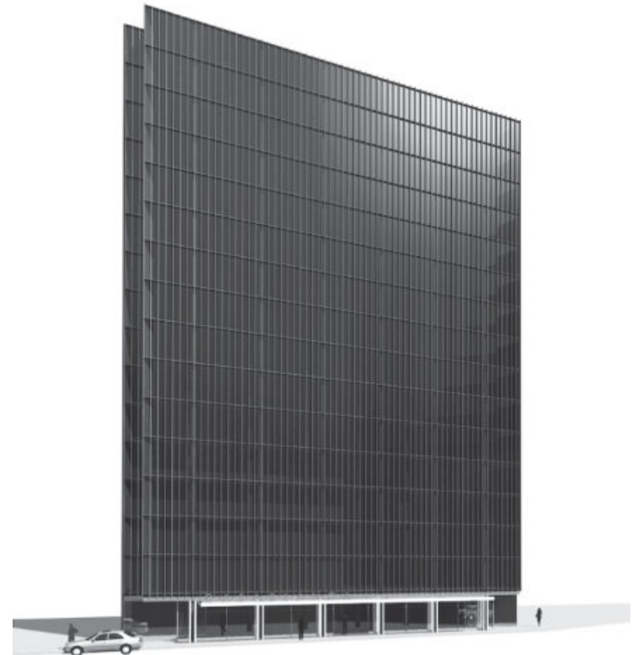
Edificio de Oficinas Casablanca
