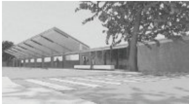
Estación de Autobuses Mollerussa, Lerida 2010 – 2012
