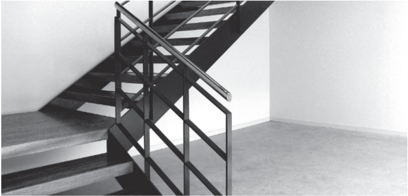
Escalera de oficinas
