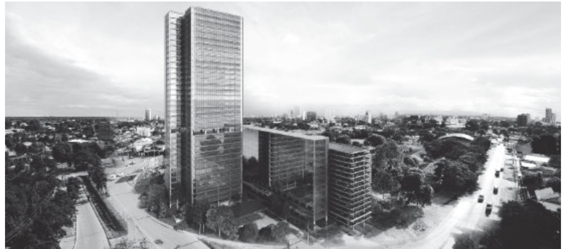
Vista general del conjunto
