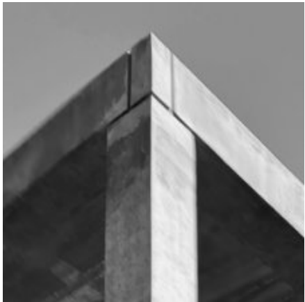
Encuentro entre viga y pilar
