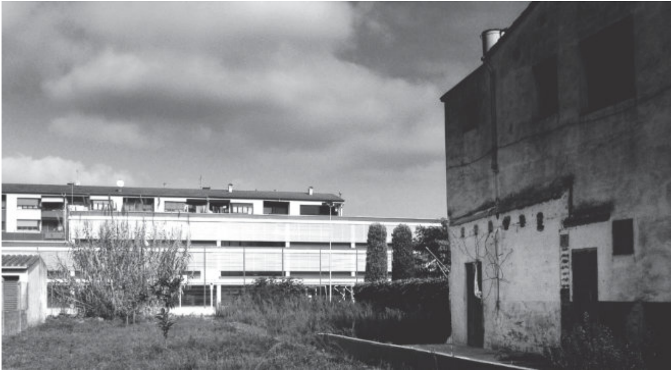
Vista del edificio desde el entorno
