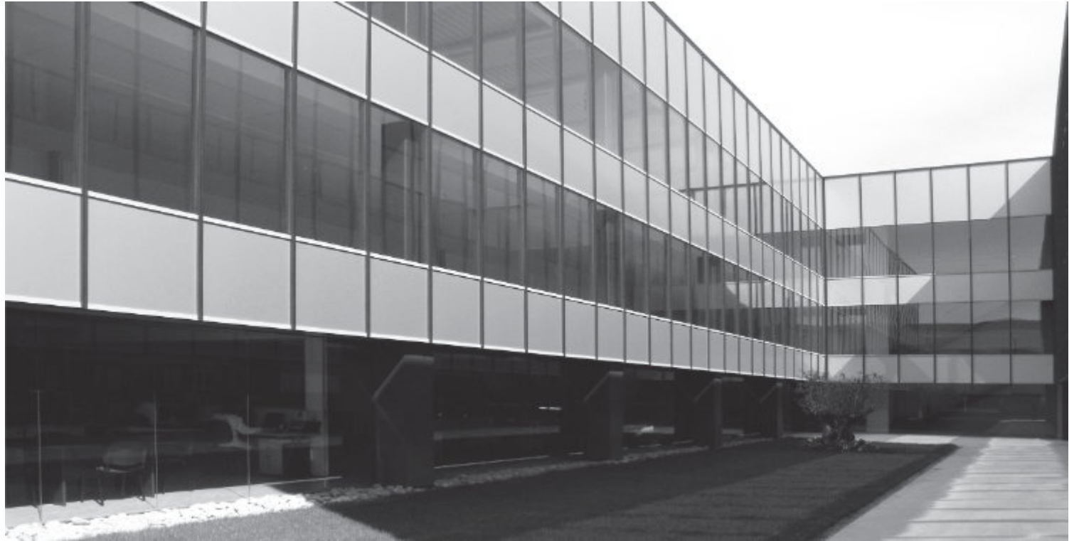
Patio de acceso / Foto aérea
