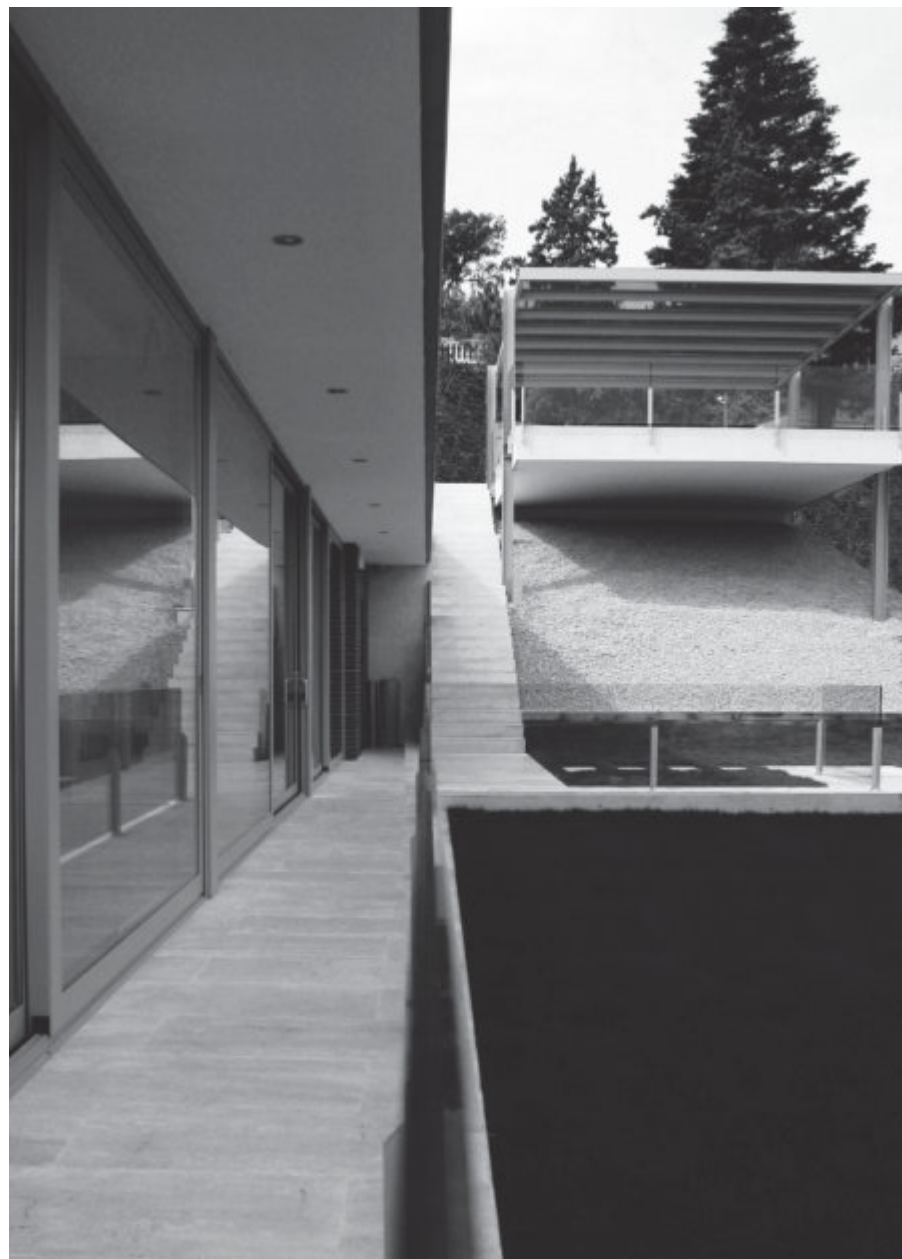
Cochera y escalera de acceso
