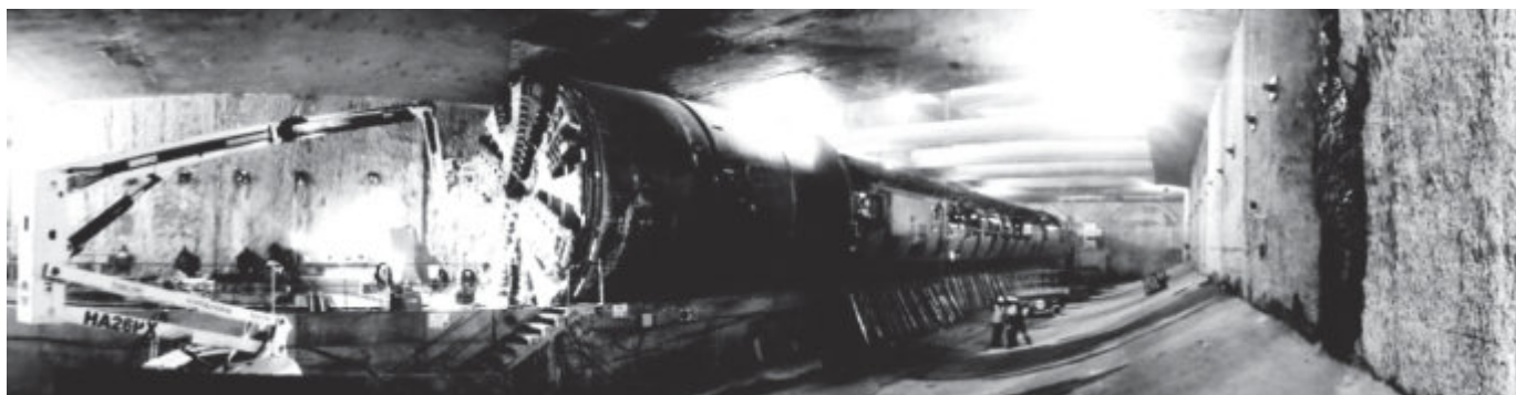
Vista panorámica del túnel Tuneladora Herrnknecht AG S-510
