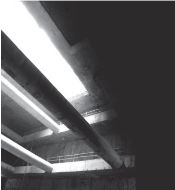
La luz natural entra por una zona del techo del túnel que aún no sido completamente cerrada
