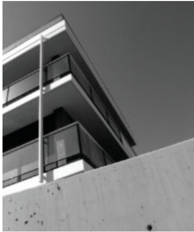
Edificio de 5 viviendas Cerdanyola, Barcelona 2005 – 2007
