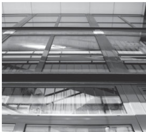
Vista exterior de las escaleras
