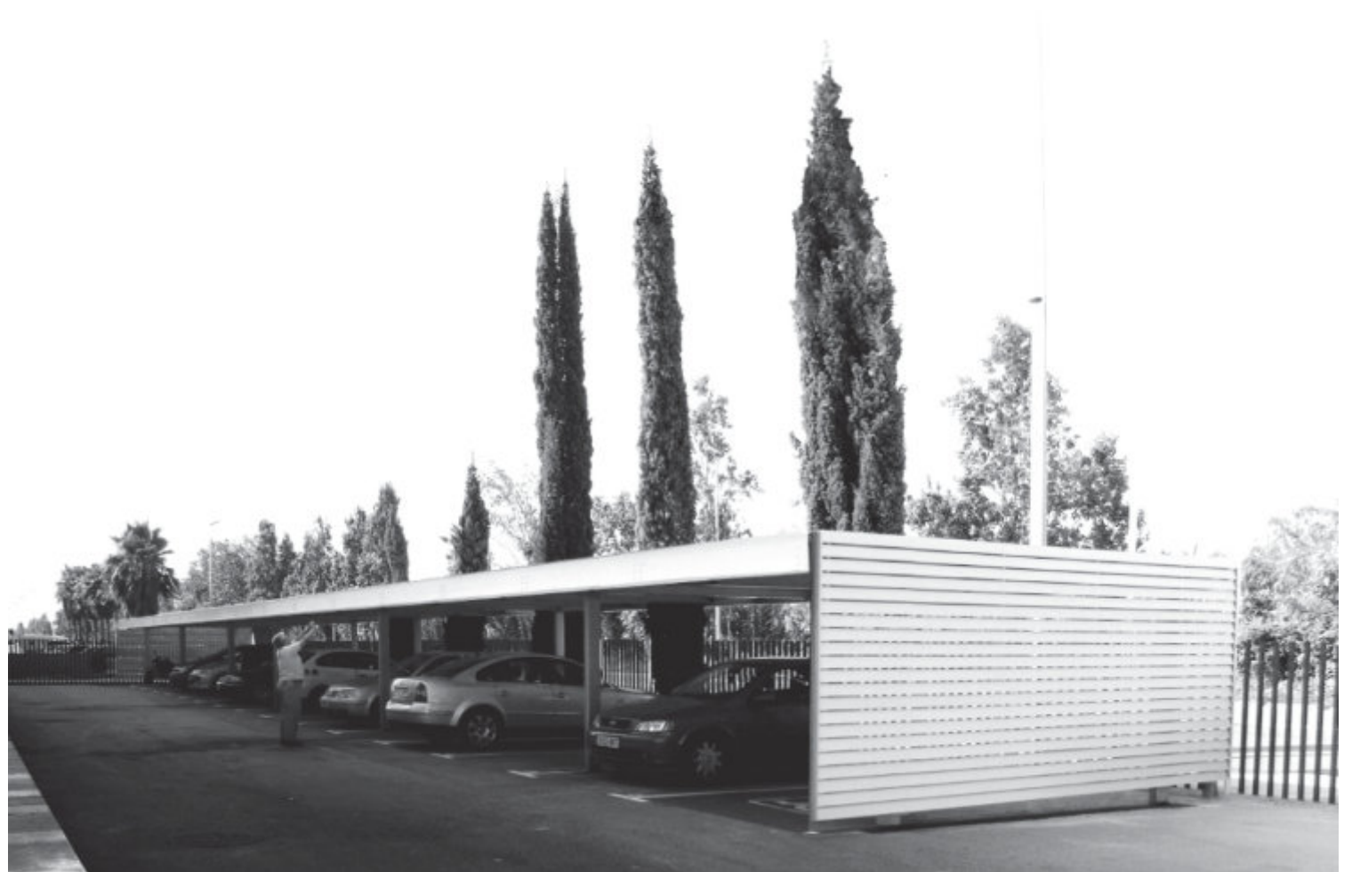
Vista general de la marquesina
