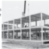
Construcción de viviendas industrializadas
