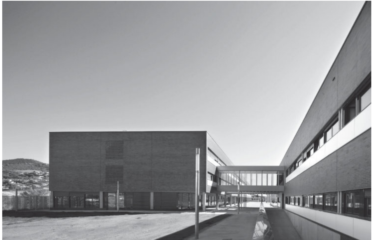
Puente y rampa da acceso
