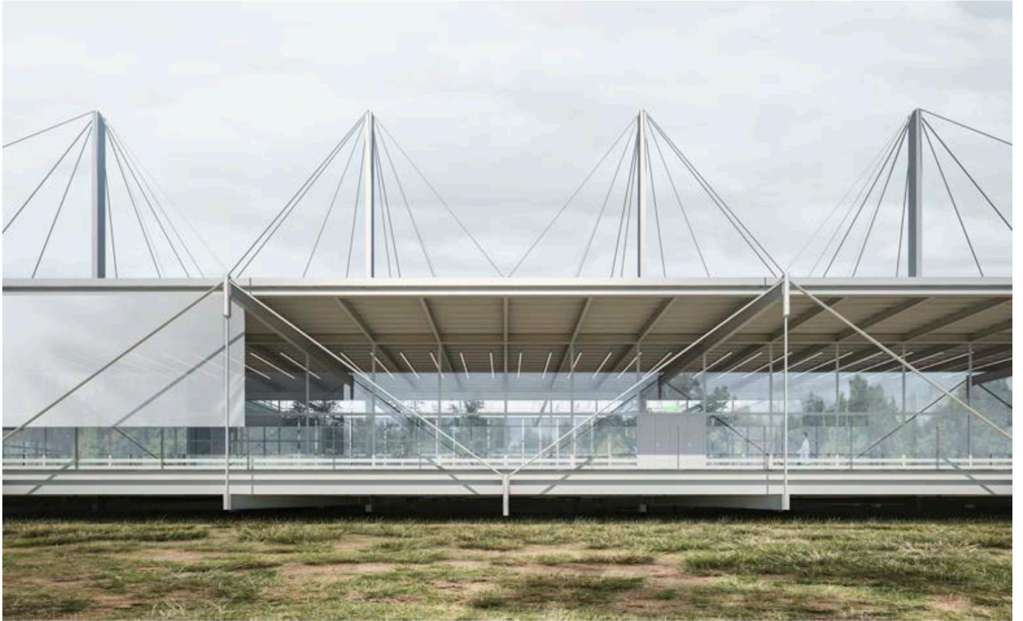
La estructura, puede asumir bien los cambios dimensionales asociados a las variaciones térmicas del emplazamiento, por la baja hiperestaticidad interna y por las características mecánicas del acero. No se contemplan juntas de expansión.
