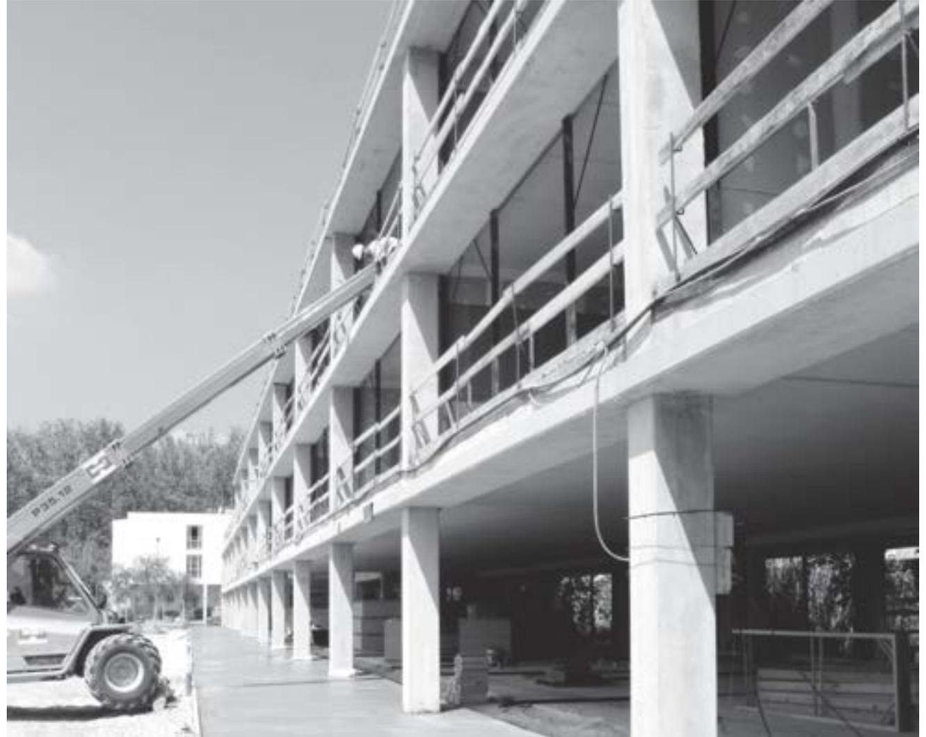
Las fachadas este y oeste se cierran con panel de hormigón micro lavado, al igual que la fachada norte, donde se han dispuesto estrechas ventanas que corren a lo largo del edificio. Las aulas, todas dispuestas, al sur se protegen por medio de una celosía de lamas fijas de aluminio que reduce la penetración de la radiación solar en el interior y tamiza la presencia del exterior en las aulas.
