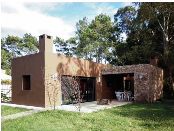
Dibujante, Colaborador en Proyecto y Asistencia en Dirección de Obra. Vivienda M.A. La Pedrera, Rocha, Uruguay. (2010) Autor: Arq. Miguel Arrospide
