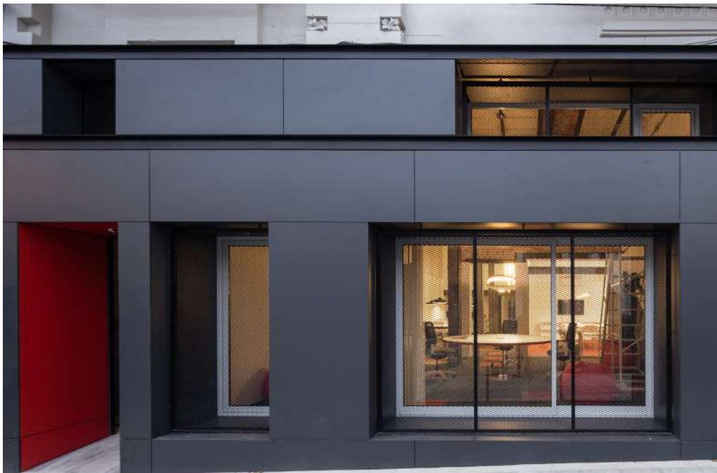
OFICINAS PABLO DE MARÍA – MONTEVIDEO / URUGUAY oficina estudio – proyecto y dirección de obra 120 m2
