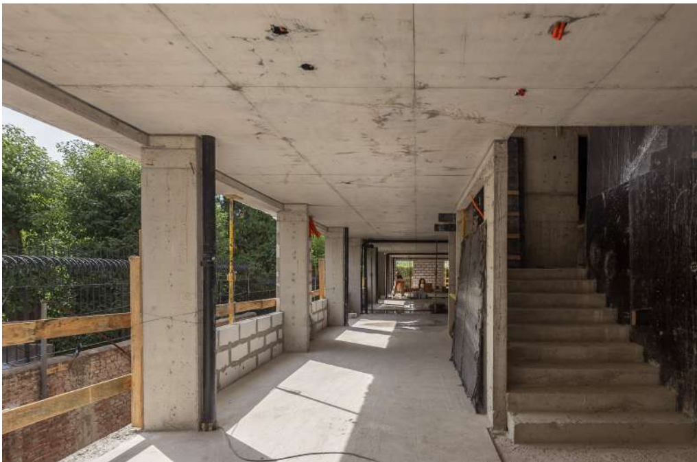
HOSPITAL BRITÁNICO – MONTEVIDEO / URUGUAY - en construcción - Senior Home 1500 m2
