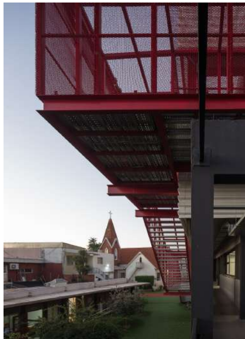
NATURAL FORCE – MONTEVIDEO / URUGUAY Etapa 2 .Reforma y Ampliación Sede Central 2500 m2.
