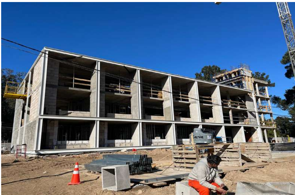
HOSPITAL BRITÁNICO- POLICLÍNICO PUNTA DEL ESTE- PUNTA DEL ESTE / URUGUAY en construcción, finaliza etapa 1 en diciembre de 2024- Nuevo Edificio de Consulta Externa e Imagenología. Anteproyecto y proyecto ejecutivo. 4.500 m2
