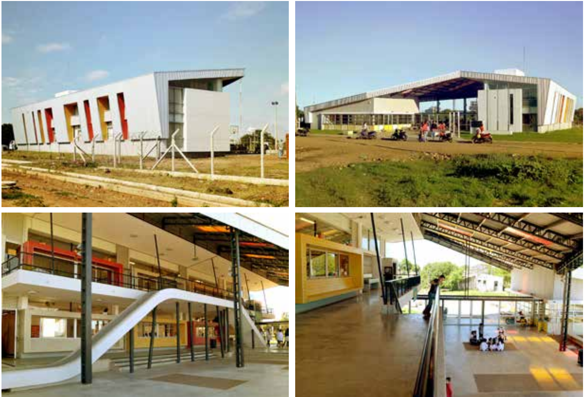
↖ Arriba izquierda: fachada lateral ↗ Arriba derecha: acceso ← Medio izquierda: fachada interna a patio → Medio derecha: patio techado
