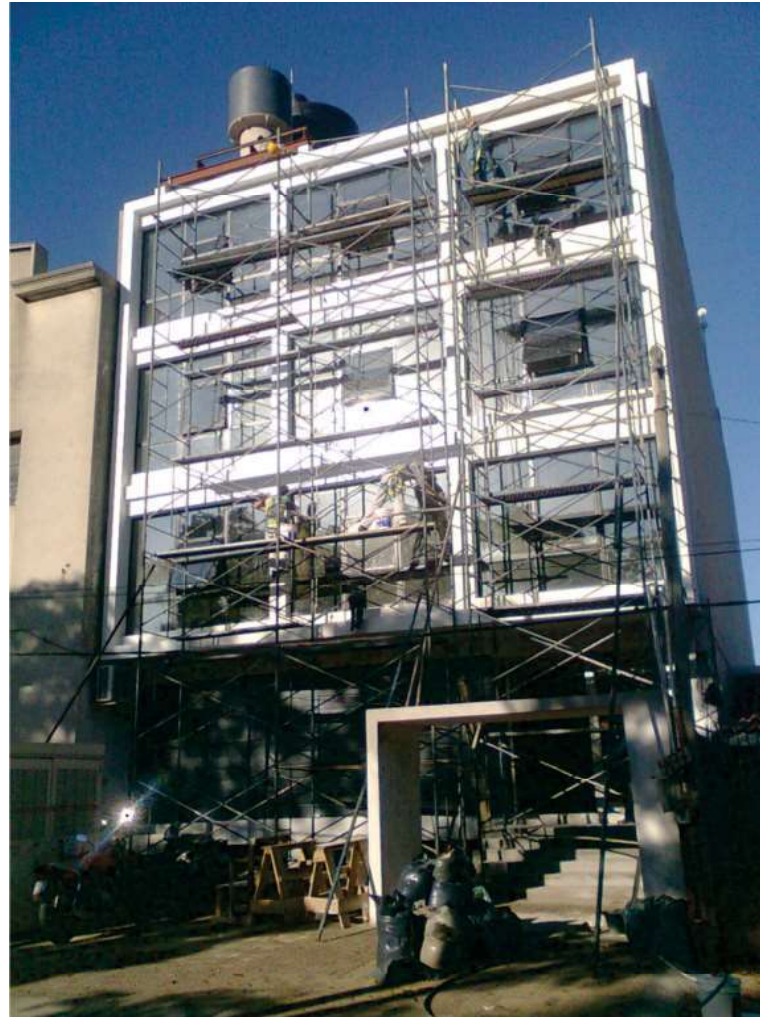
Vistas de la obra de Oficinas y depósitos en construcción.
