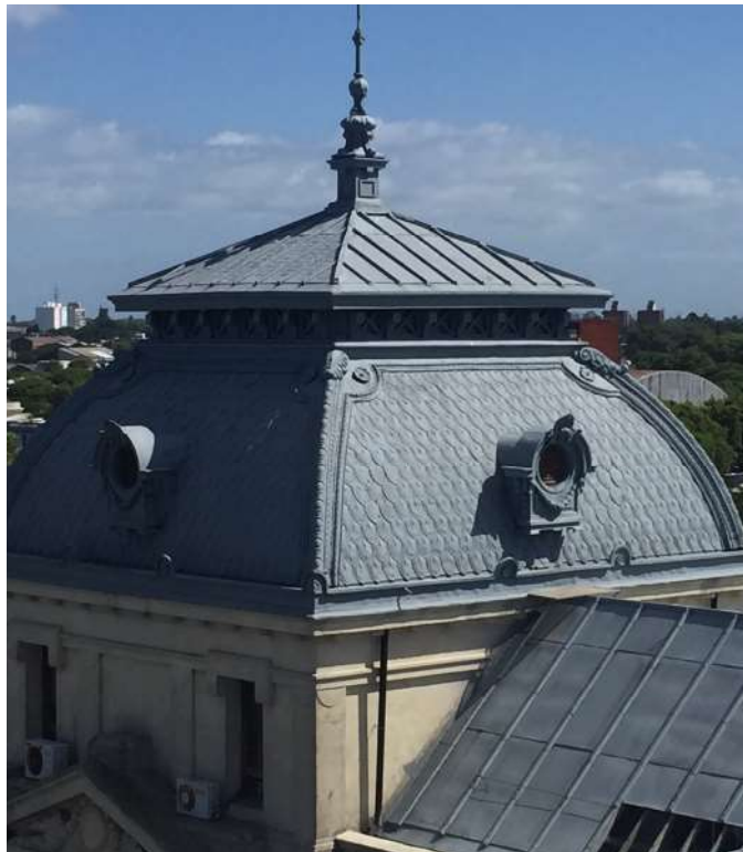
Vista de las cubiertas livianas reacondicionadas del Edificio Central de la Facultad de Medicina.
