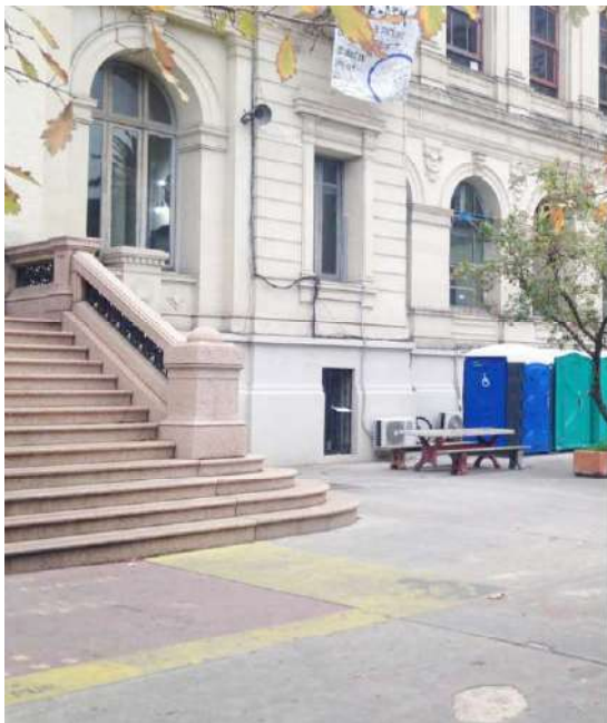
Vista de la situación pre-existente del acceso al Edificio Central de la Facultad de Medicina.
