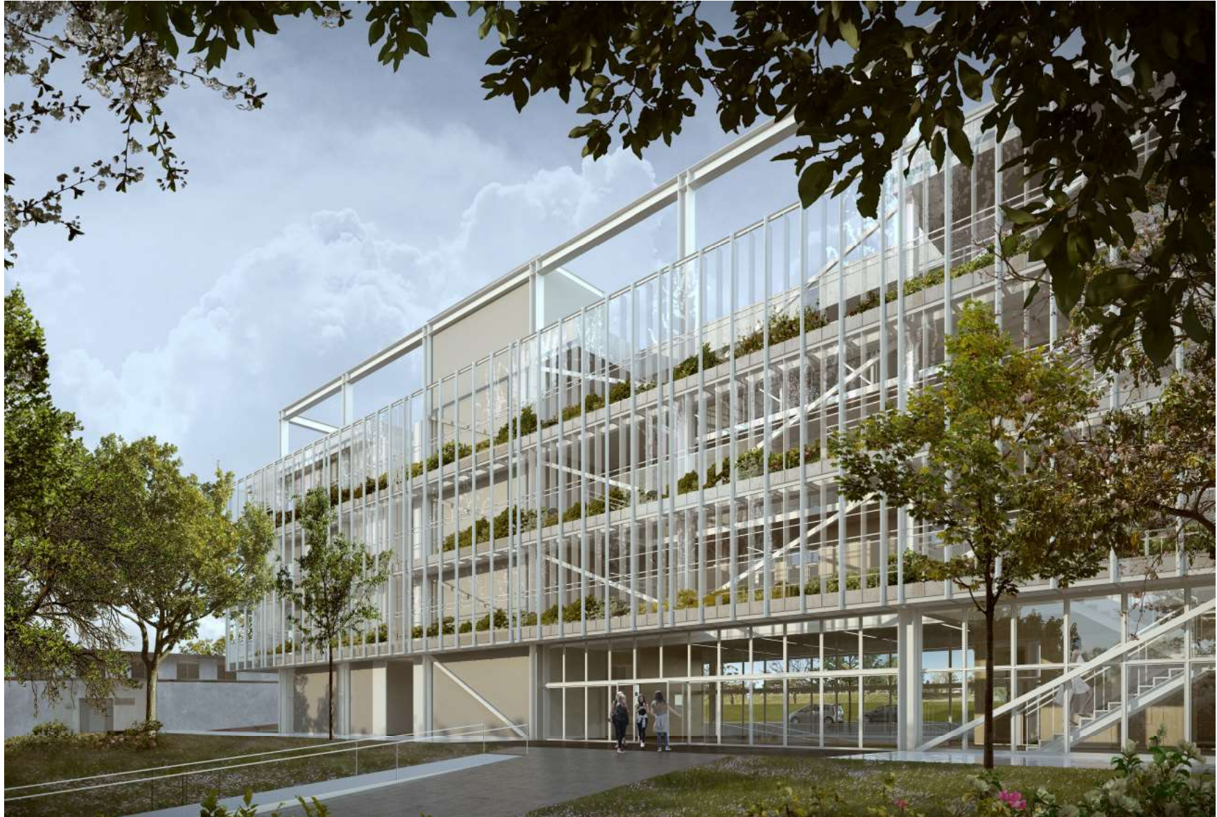
Vista del edificio sobre la calle Zorrillade la Nueva Sede Universitaria en Paysandú desde el jardín universitario. DGA Udelar.
