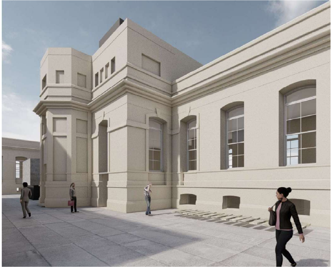
Vista de la actuación en fachada para dar ingreso al nuevo ascensor accesible en el Anexo I.
