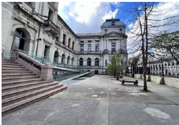
Vista de la situación existente del patio de acceso del Edificio Central.
