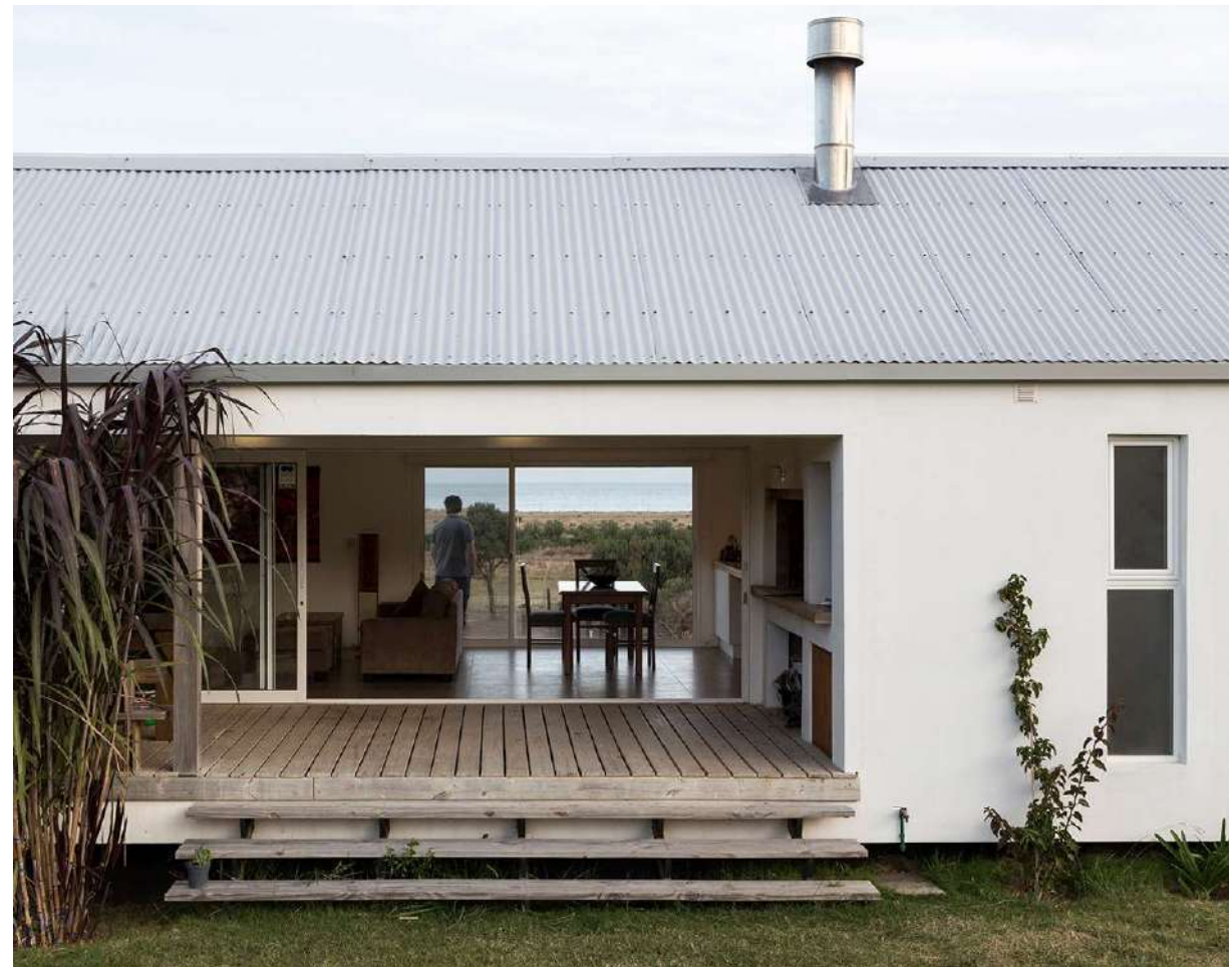
Vistas de la casa en Punta Negra.
