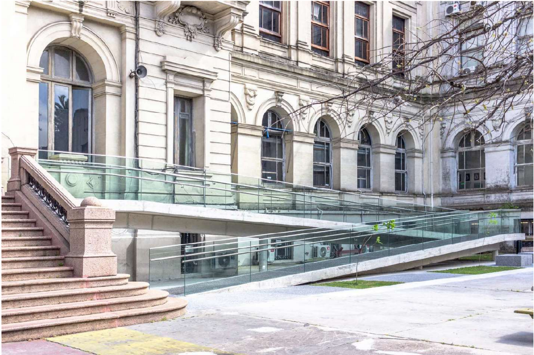
Vista de la rampa de Accesibilidad Universal al Edificio central de la Facultad de Medicina y el acondicionamiento parcial de la plaza de acceso.
