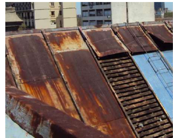
Vista del estado pre-existente de las cubiertas livianas del Edificio Central de la Facultad de Medicina.
