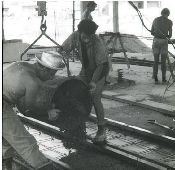
Fotografía de llenado de losetas en planta de prefabricación. Archivo IH, FADU.
