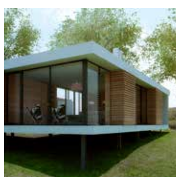
MODELO PARA ARMAR Vivienda unifamiliar en Altos de la Tahona Año: 2013 Programa: Vivienda unifamiliar Cliente: Privado Ubicación: Montevideo, Uruguay Área: 150 m 2
