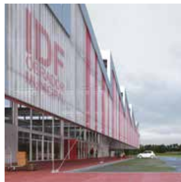
CND OBRADOR Cubierta y plataforma multipopósito Obrador Intendencia Departamental de Flores. Año: 2022 Programa: Obrador Municipal Cliente: IMF Ubicación: Flores, Uruguay Área: 12300m 2
