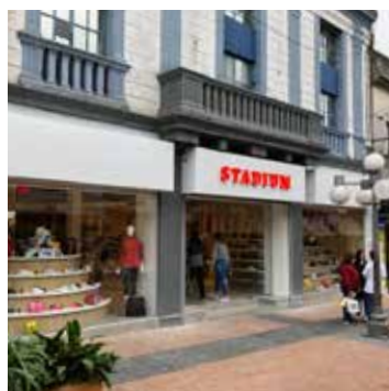
STADIUM SAN JOSÉ Local comercial Stadium Calzados Año: 2019 Programa: Local Comercial Cliente: Stadium Ubicación: San José de Mayo, Uruguay Área: 314 m 2
