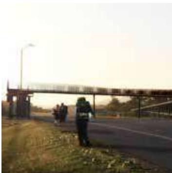
PA(I)SAJES PEATONALES Concurso Licitación Internacional para la construcción de pasajes peatonales sobre la ruta IB Año: 2012 Programa: Infraestructuras viales Cliente: MTOP Ubicación: Canelones, Uruguay
