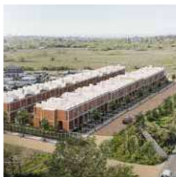
FISU PLAN AVANZAR Llamado para proyecto-precio para realojos plan avanzar Año: 2023 Programa: Viviendas Cliente: MVOT Ubicación: Montevideo, Uruguay
