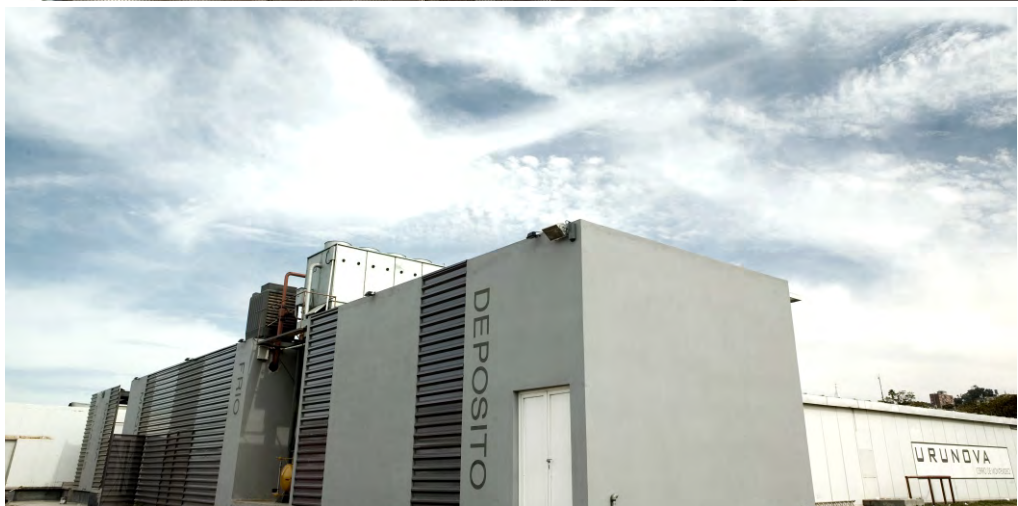
FRIGORIFICO URUNOVA SRL / 2007 / reciclaje y obra nueva / Cerro / Montevideo - Uruguay
