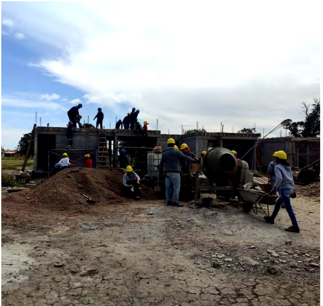
50 VIVIENDAS Y SALON COMUNAL / COOPERATIVA DE VIVIENDA COVIPINO 1 / RINCON DEL PINO - SAN JOSE / EN CONSTRUCCION
