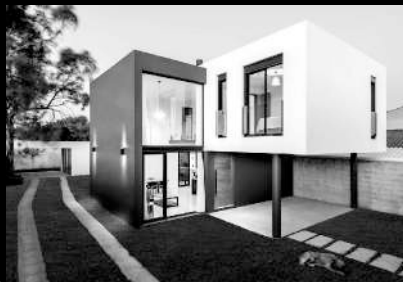
P01-06. TRABAJOS REALIZADOS EN E.P.A.
