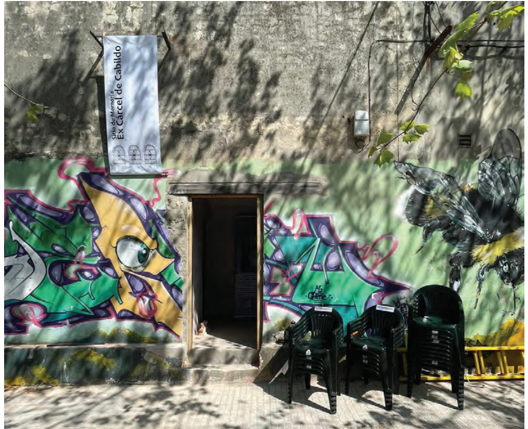
Nuevo acceso a calle Acevedo Díaz. s/n. 2022
