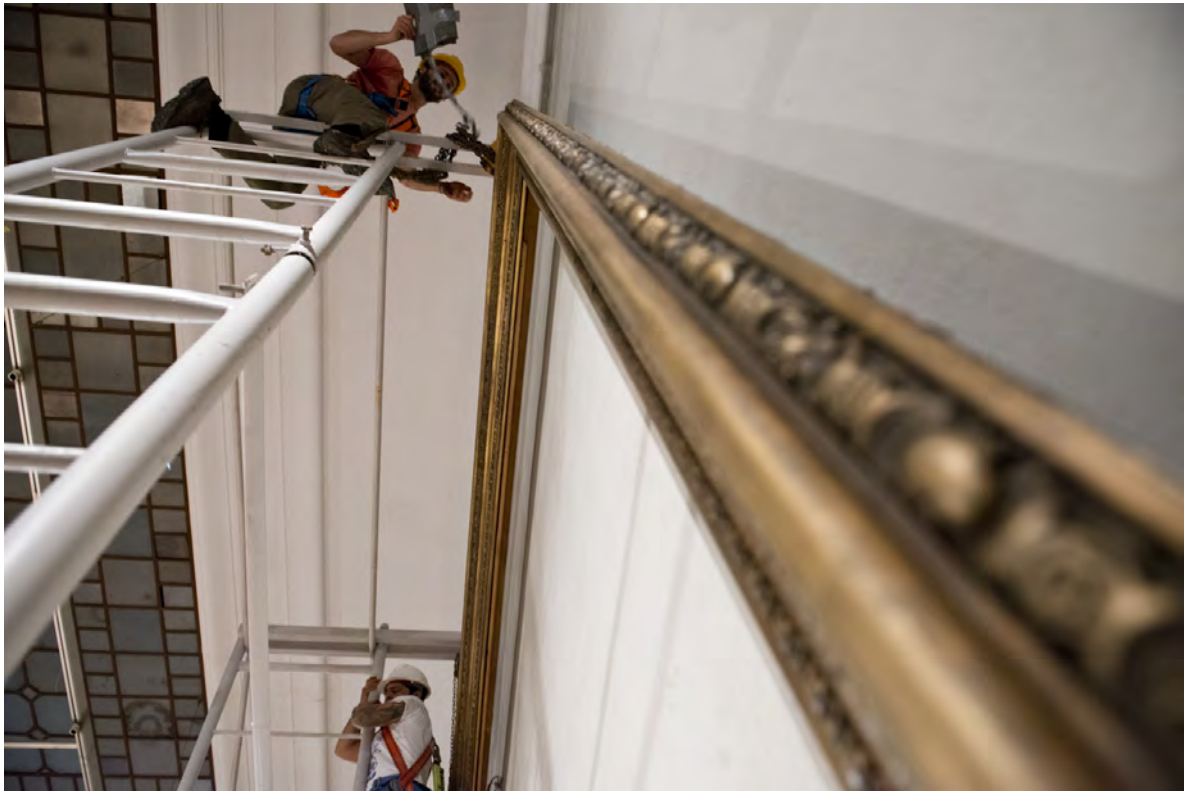
Estructura para los trabajos de restauración del Juramento de los 33 Orientales
