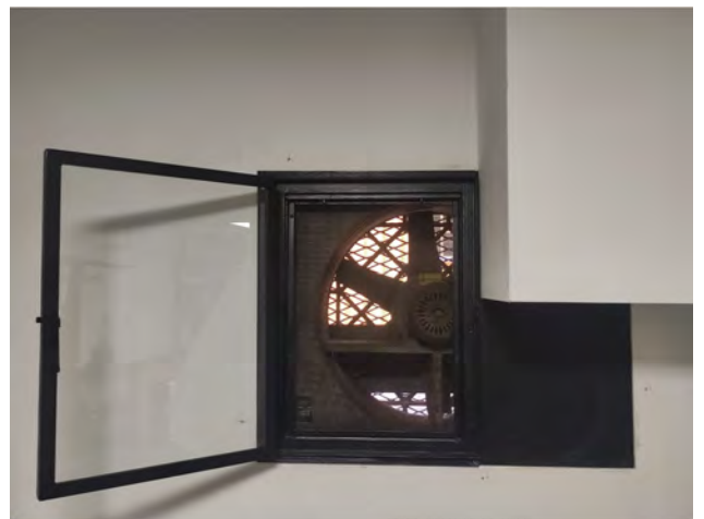
Ejemplos de la restauración de las aberturas de las reservas. Ubicación: subsuelo. Acciones: colocación de filtros y vidrios. Reparación de extractores e instalación de hojas batientes. Museo Blanes. 2019 - 2022.
