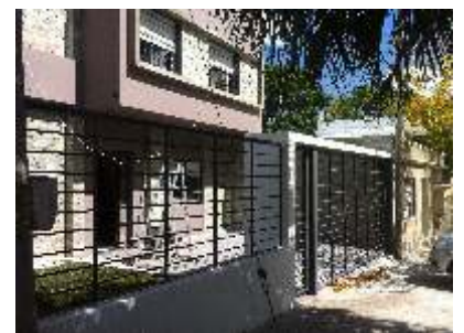
Reforma vivienda Lijan Cafasso
