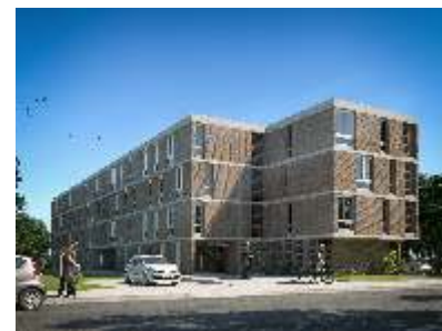
Viviendas Zum Felde activos - Grupo Transamerican S.A.
