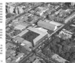
aprovechamos el edificio reconstruido, casi siempre, en su totalidad.
