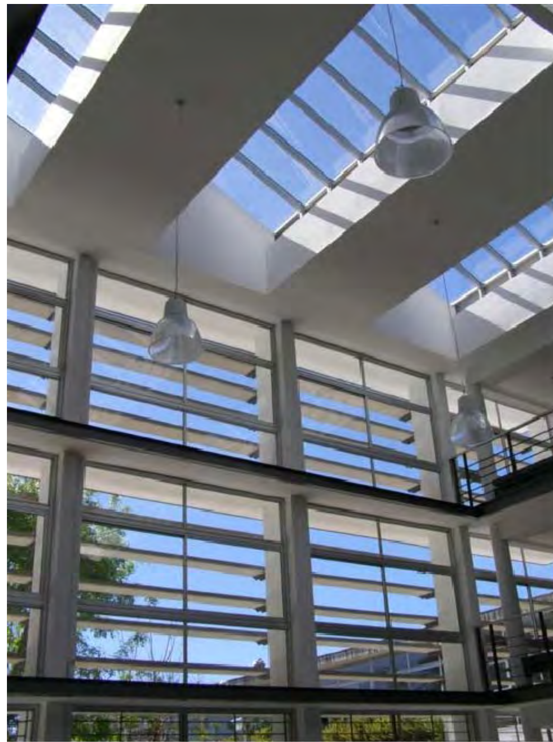
lucernario hall central - abertura al patio de escuela anexa
