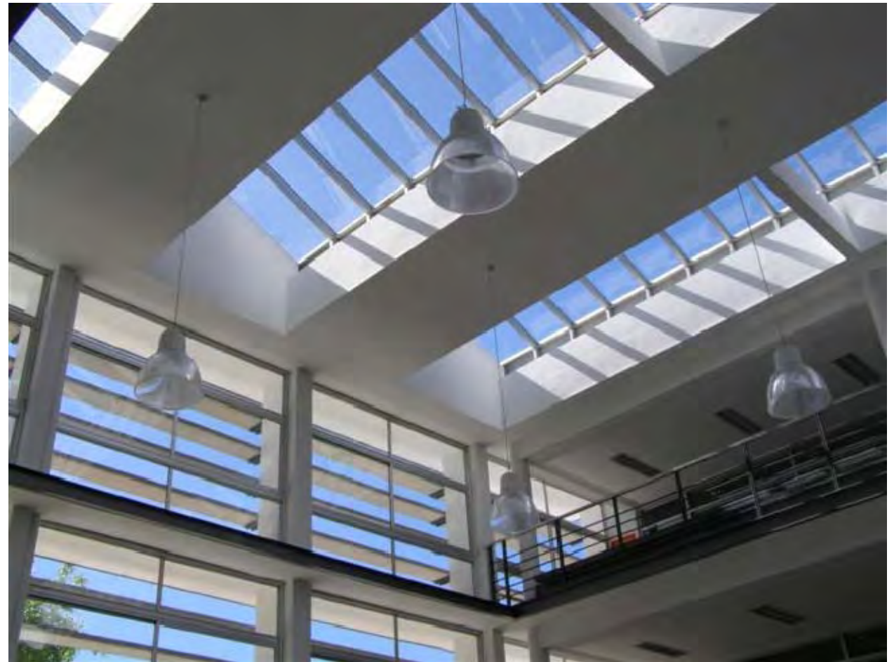
lucernario hall central - abertura al patio de escuela anexa
