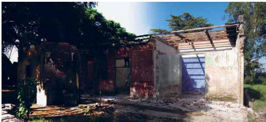
Imágenes proceso de obra
