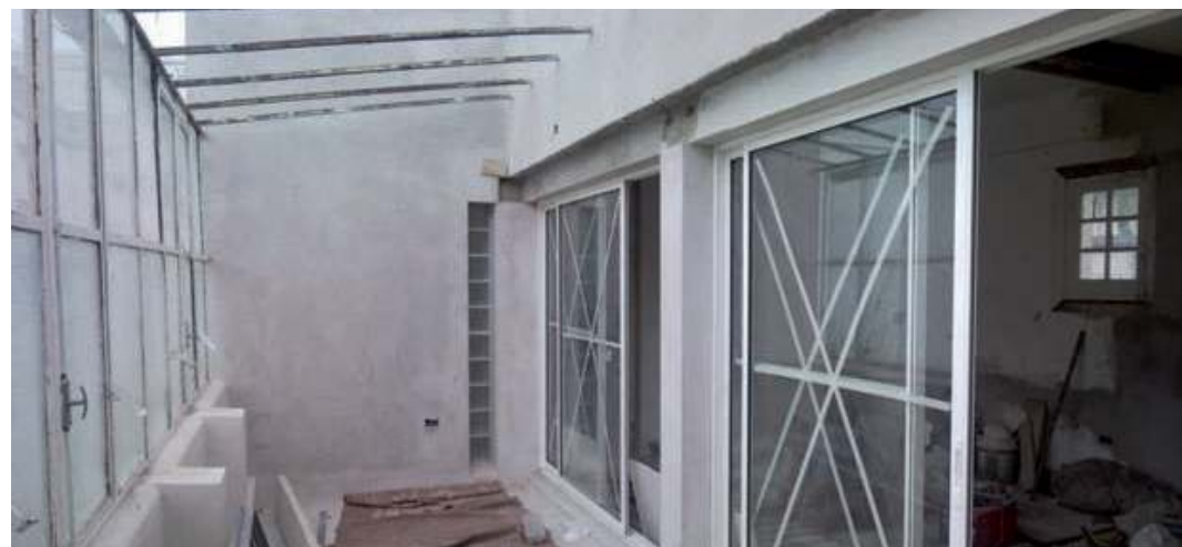
Imágenes proceso de obra
