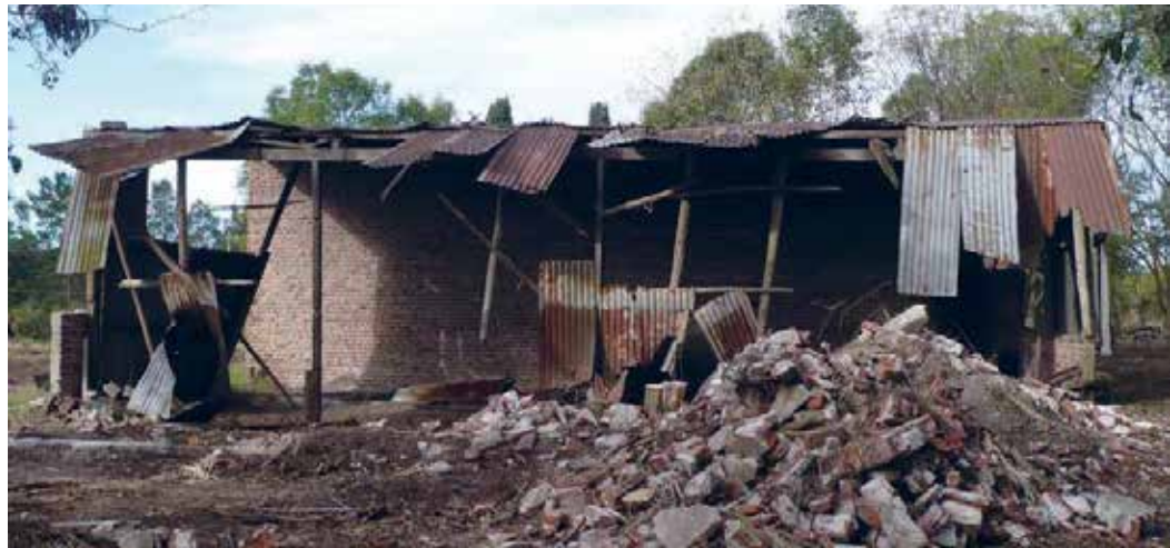
Imágenes estado inicial
