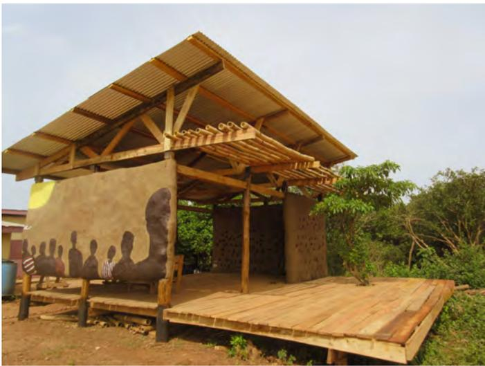
Se realizó la técnica Fajina en los muros a partir de una estructura de madera. La mayor parte de los materiales utilizados provinieron del lugar. En la actualidad el espacio es usado con gran satisfacción por parte de los destinatarios.
