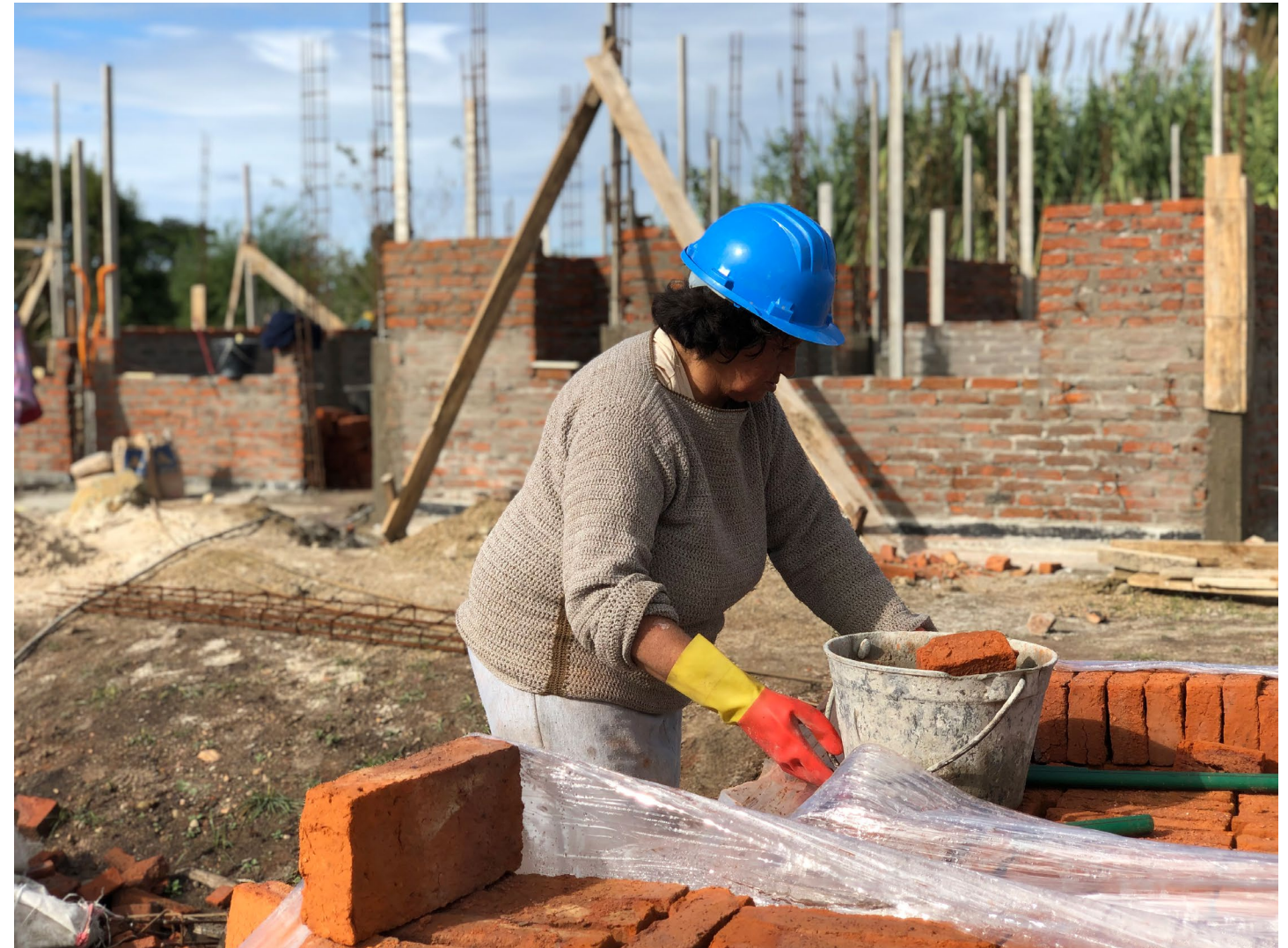
Obra MEVIR Estación Tapia
