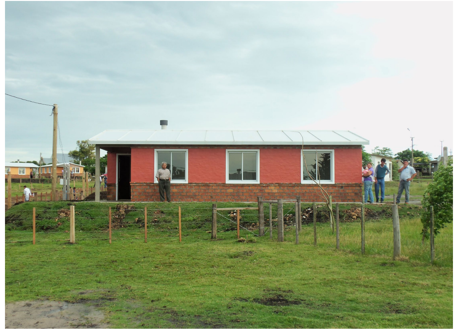
Obra piloto, donde se experimentó la utilización de la cubierta de Isodec e instalación eléctrica embutida.
